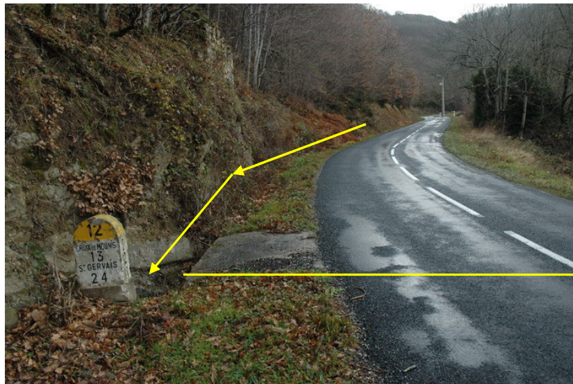
Figure 2 : Le caniveau de la route colmaté par tronçon depuis le carrefour de Sials, recueille les eaux pluviales. Un ouvrage sous la route déverse ces eaux dans le chemin conduisant au captage (flèche jaune de la figure 1).
