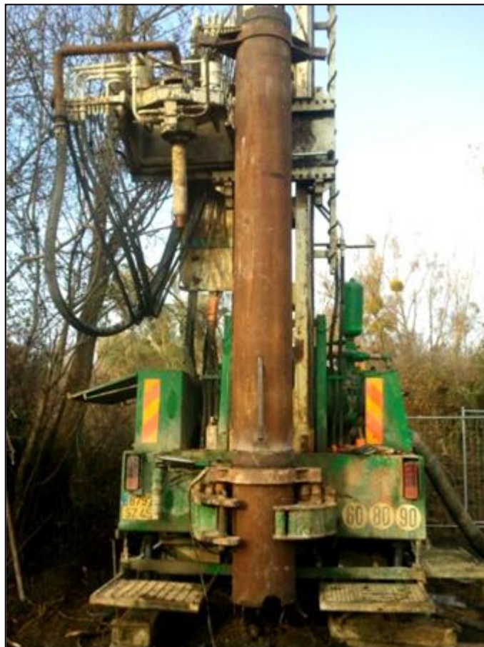
Figure 4 : Pose du tubage 457 mm
