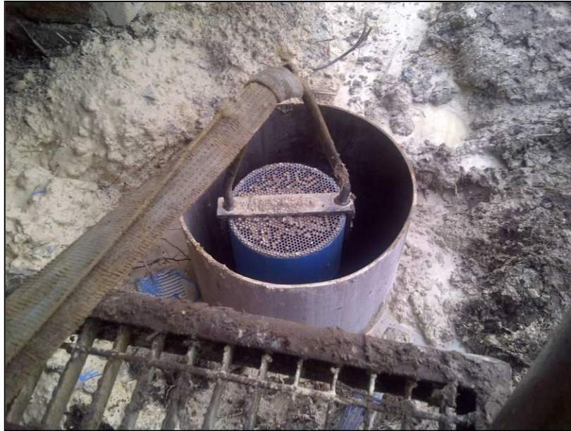
Figure 6 : Tube PVC en place en cours de gravillonnage
