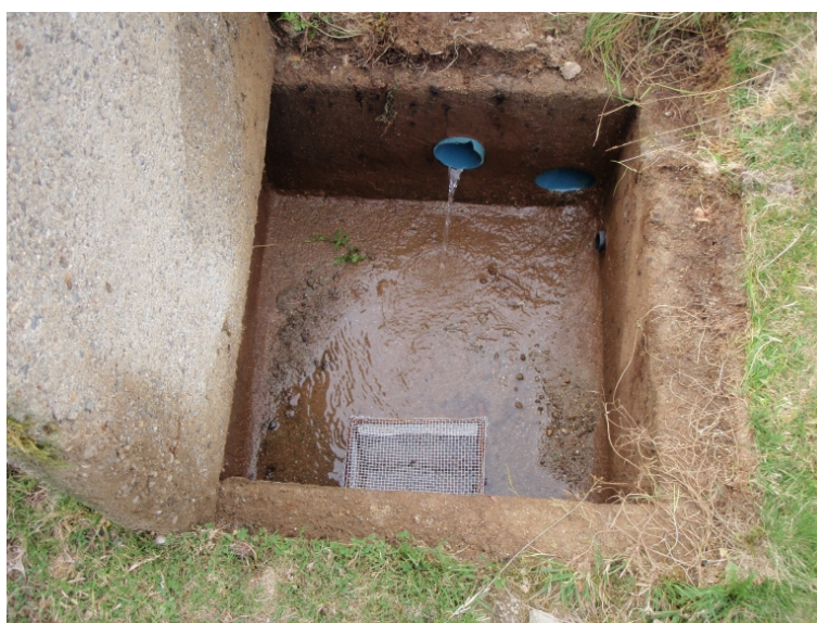
Photographie n° 2 : vue intérieure du captage : arrivées d'eau des « drains » (tubages bleus), prise d'eau pour l'abreuvoir (canalisation grise) et grille « de protection » de la canalisation de prise d'eau pour l'alimentation de la cabane pastorale (voir photographie n° 3).
