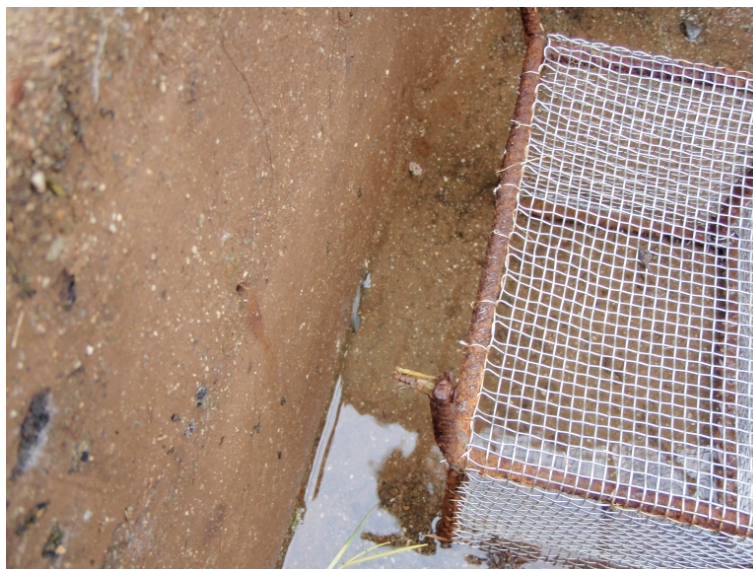
Photographie n° 3 : vue intérieure du captage : prise d'eau pour l'alimentation de la cabane pastorale (canalisation grise en fond d'ouvrage) et « crépine » (déplacée momentanément pour la prise du cliché).
