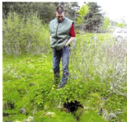
exutoire du trop plein sans clapet
