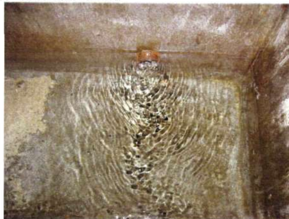
Arrivé des drains – fond en terrain naturel
