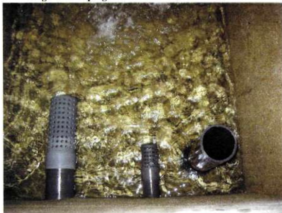
Crépines de départ et bonde surverse-vidange
