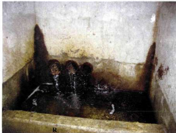
Bac de décantation - arrivée des trois drains
