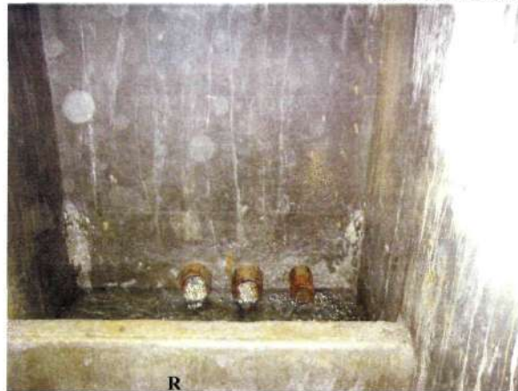
R Arrivée Conduite Hervé 1 et drain Hervé 2
