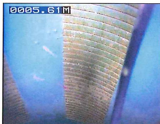
Premiers dépôts sur les crépines sans pour autant les obstruer
