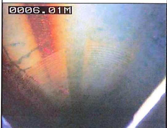
Dépôts d'oxyde de fer sur le tubage
