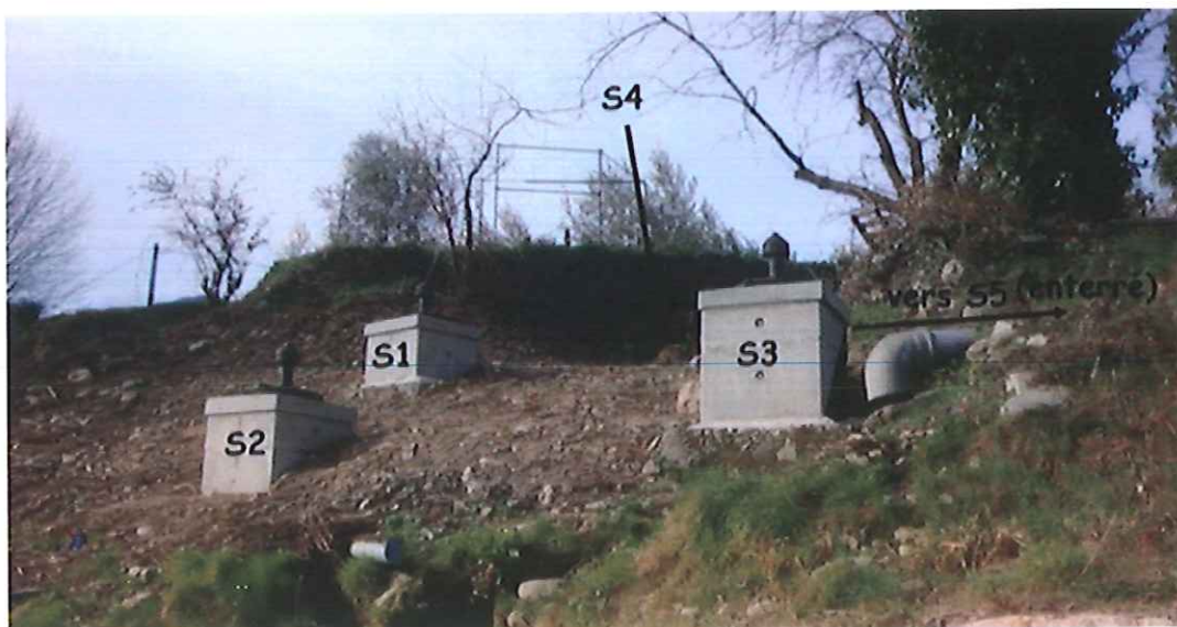
Figure 2 : Captages S1, S2 et S3 réhabilités, ainsi que S4 non réaménagé
