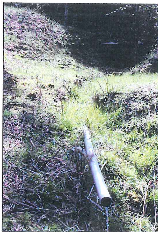
Photo 10 : Déversoir de trop plein de la source n° 5
