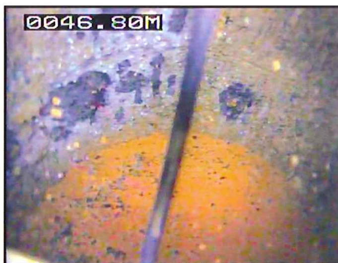
Figure 6 : Fond de l'ouvrage et débris apparents
