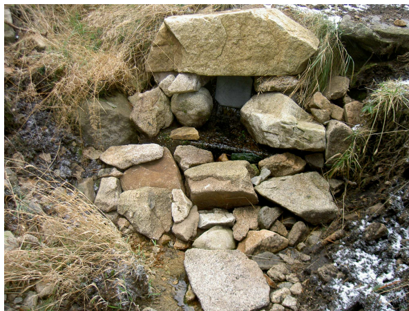
Trop plein existant et clapet à dégager
