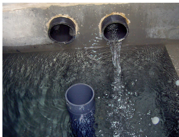
Les arrivées à l'intérieur du captage
