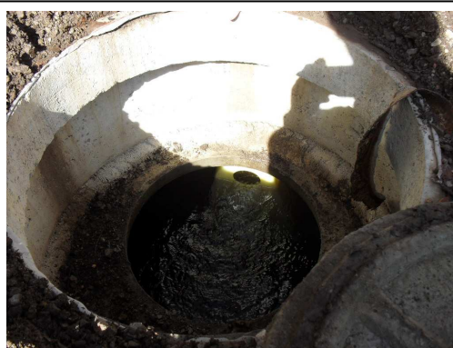
Figure 4 Collecteur, arrivée du drain.
