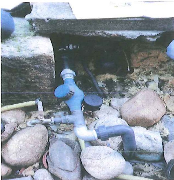
La tête du forage du Mas Béarn équipée d'un compteur, d'un filtre à sable et d'un robinet d'eau brute, le 12 avril 2013.
