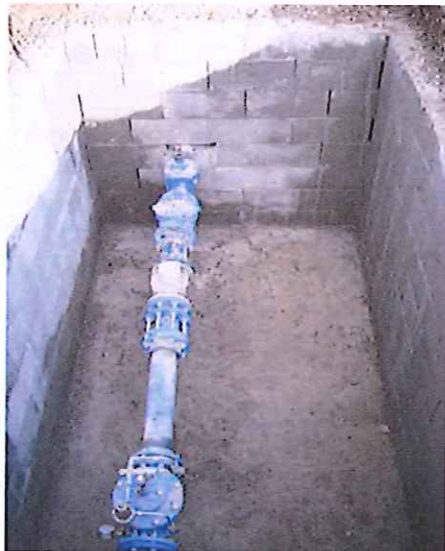
Nettoyage des déblais du fond de la chambre à vanne.
