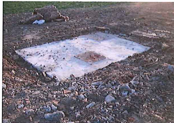
Dépose de la dalle au droit de la chambre à vanne.
