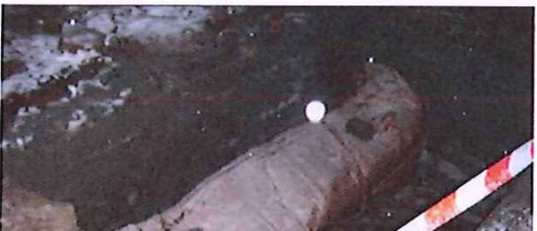
Calorifugeage (provisoire) de la canalisation
