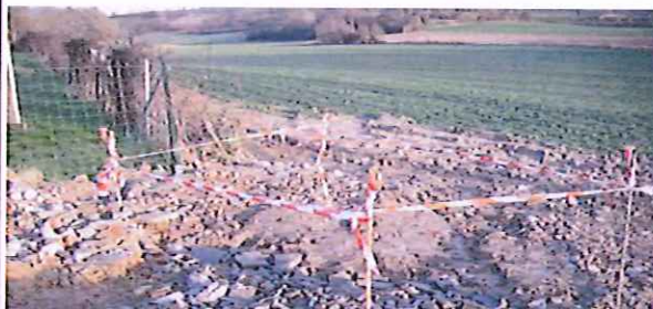
Zone de remblaiement du puits balisée.
