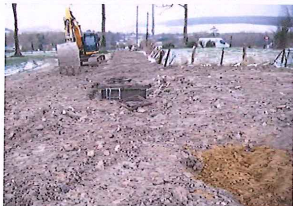
Puits remblayé jusqu'à 15 cm sous le niveau naturel
