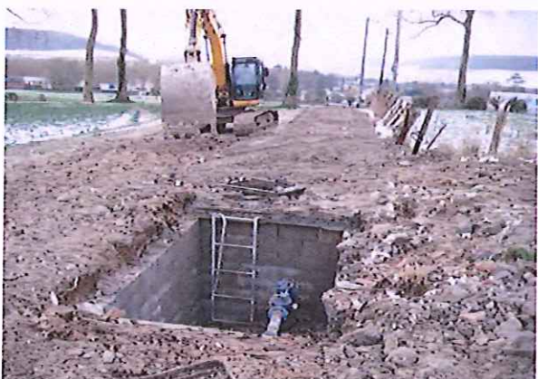
Chemin d'accès refait (matériaux compactés à la pelle à chenilles)
