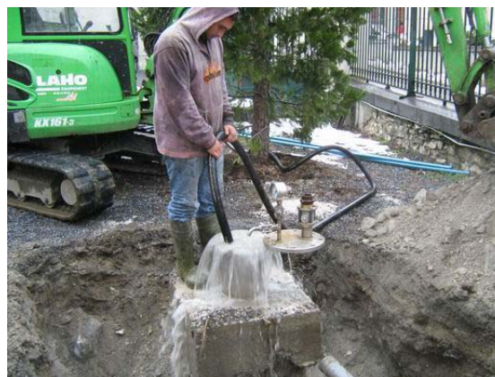
Figure 8j : Complément de cimentation
