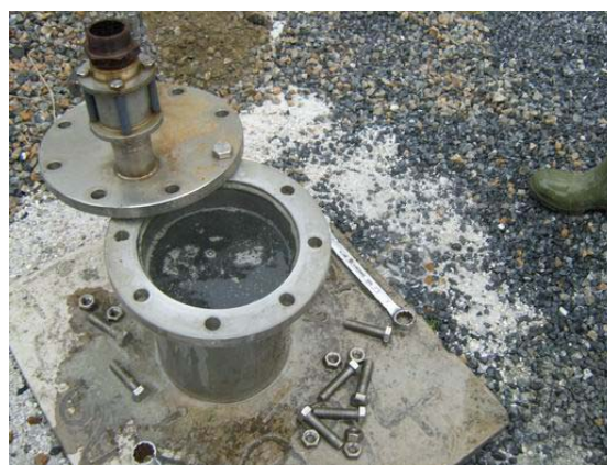
Figure 8h : Ouverture du forage après cimentation
