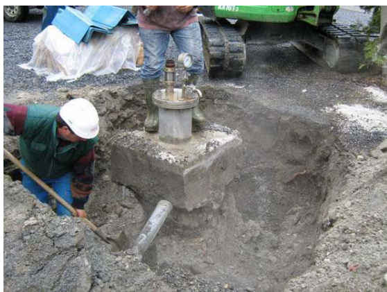
Figure 8i : Déroctage autour du tube inox
