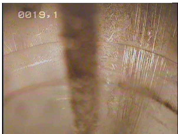
Photo 4 : 4 ème joint de tubage avec traces d'outil
