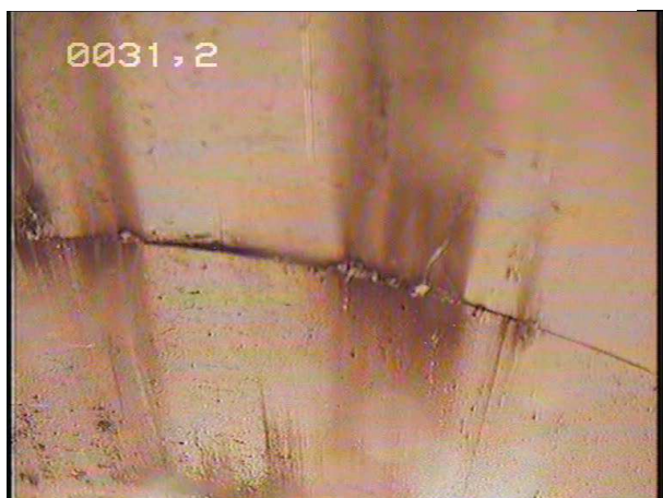
Photo 3 : 6 ème joint de tubage avec marques de soudure
