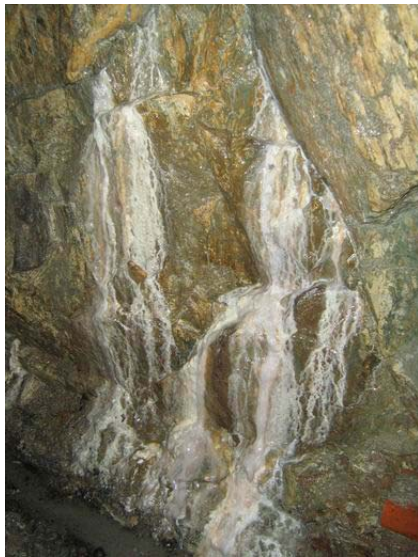
Figure 10c : Ecoulements d'eau sulfurée avec barégines le long de la paroi de la galerie
