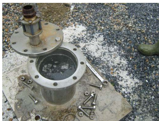
Figure 8h : Ouverture du forage après cimentation
