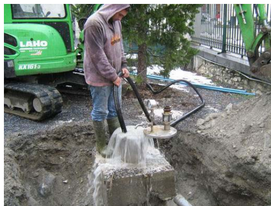
Figure 8j : Complément de cimentation
