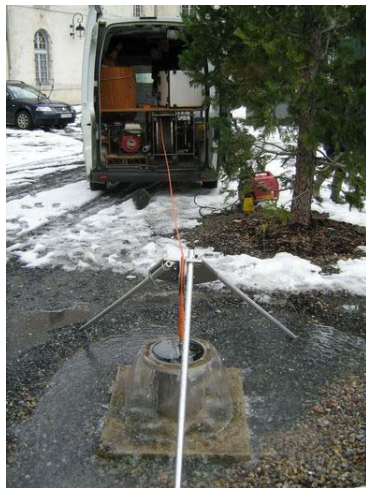
Figure 8c : Réalisation de l'inspection vidéo
