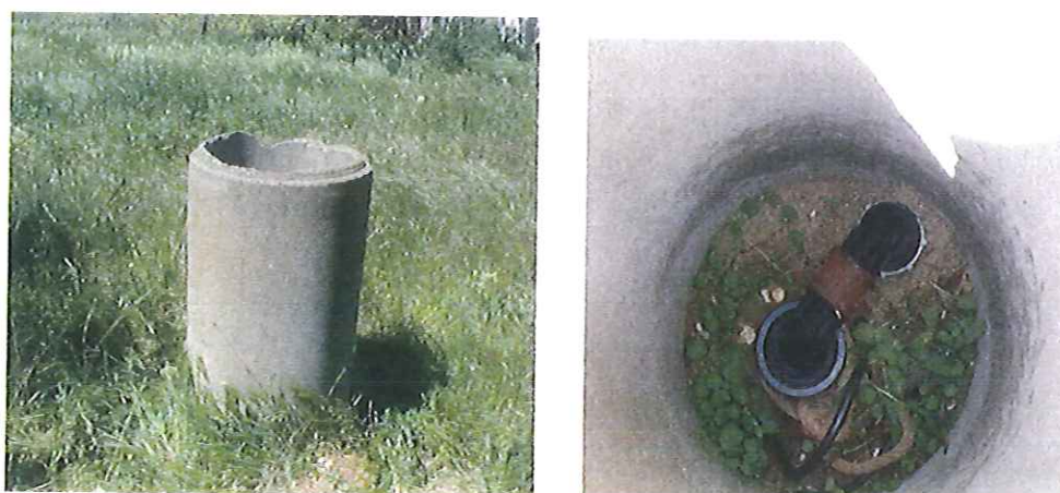
Figure 4 : Photos de la tête du forage actuellement exploité pour l'alimentation du mas Camomille avant travaux de réaménagement
