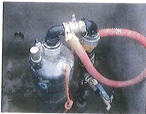
Figure 5 : Photos de la tête du forage actuellement exploité pour l'alimentation du mas Camomille après travaux de réaménagement
