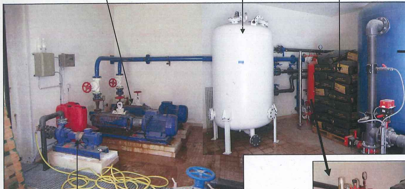
Pompe d'injection de chlore asservie au compteur de production
