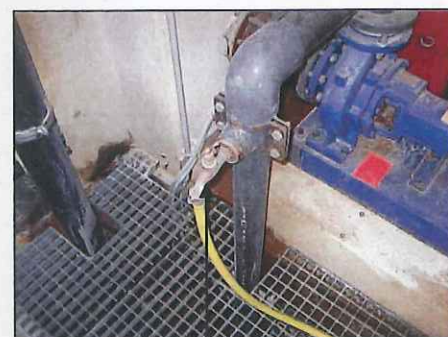
Robinet de prélèvement d'eau désinfectée
