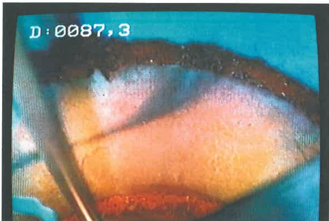
16- Cône de réduction – dépôts sur la bordure supérieure
