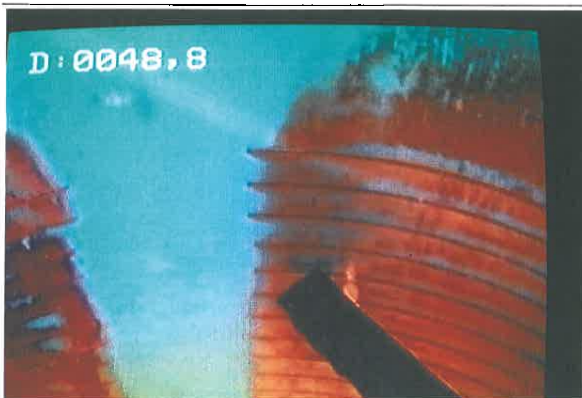
9- Tubage PVC crépiné – légers dépôts, fentes plus ou moins colmatées
