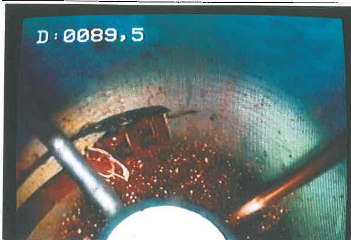
17- Tubage PVC crêpiné – légers dépôts, fentes partiellement colmatées
