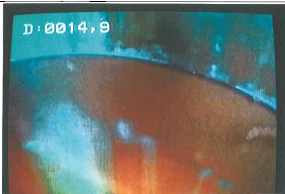
5- Tubage PVC lisse – dépôts tapissant le tubage et raccord inter-tubes
