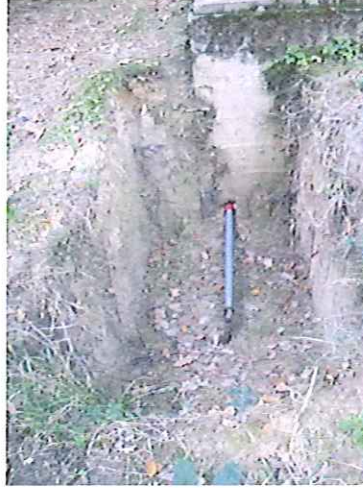
Figure II-10 : excavation dans les sables, vue de la tête de la pointe filtrante
