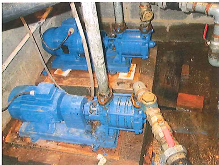
Figure II-9 : les pompes avec à la verticale, le tube d'aspiration, et à l'horizontale le refoulement vers les ballons.
