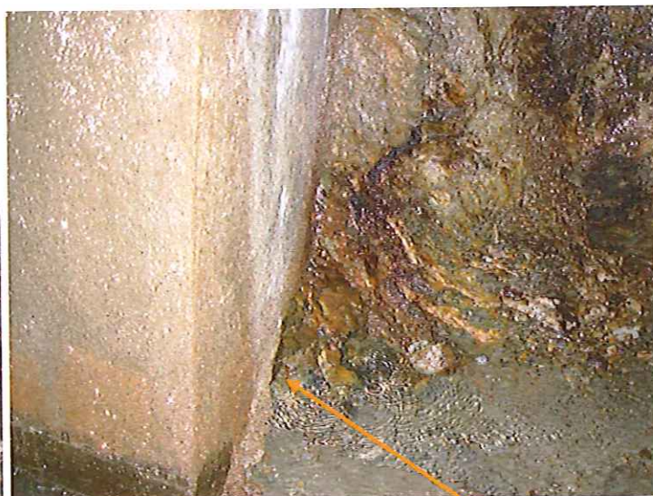
Début de la galerie. Arrivée d'eau par un orifice à la base de la paroi maçonnée
