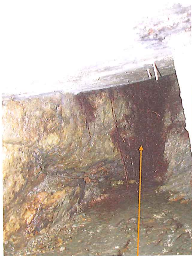
Intérieur de la galerie captante Racines sur la paroi du fond
