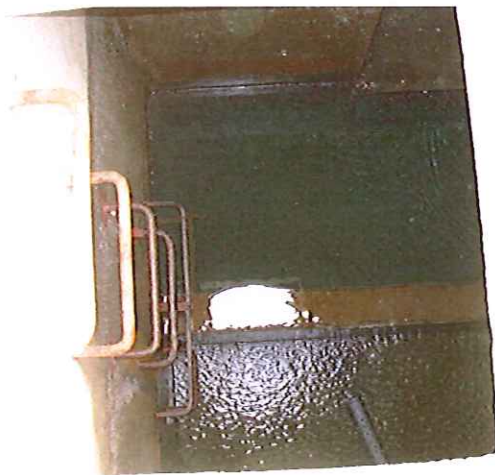
Intérieur du captage vu depuis l'accès Bac de dessablage (en haut) et bac de prise d'eau
