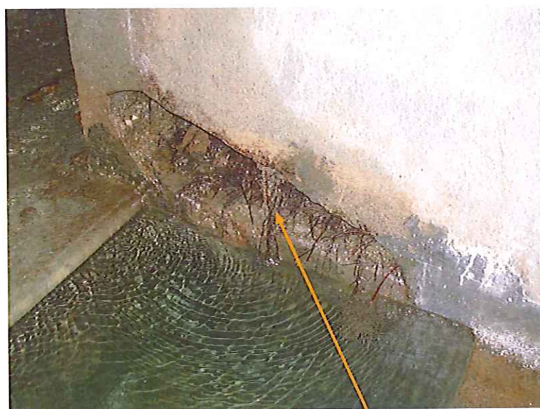
Trou dans la paroi du captage. Arrivée d'eau et racines
