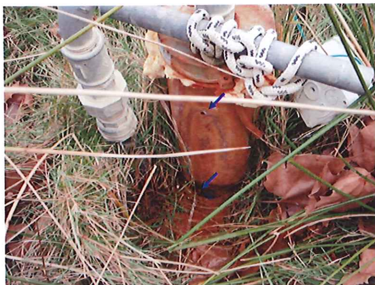
Photographie n° 2 : vue des perforations de la tête de forage (flèches bleues), état au 19/12/12 (Cliché J.-L. LENOBLE).
