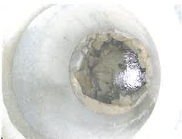
Photo 5 : Intérieur du captage ancien (buse en béton au dessus et pierres maintenues en bas).
