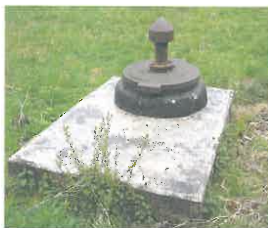
Photo 4 : Captage récent avec une dalle cimentée et un capot Foug.
