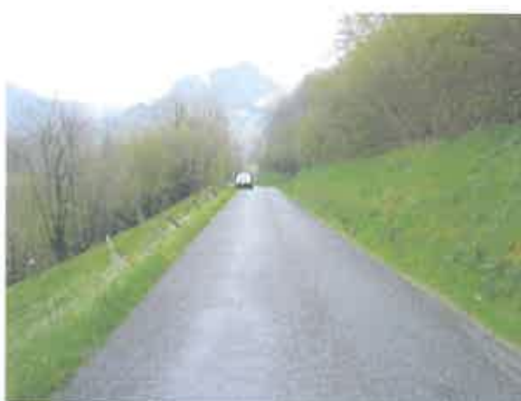
Photo 10 : Vue de la section de la RD7 au dessus du captage. La route est en devers droite avec présence d'une rigole de récupération des eaux pluviales)
