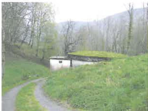
Photo 7 : Réservoir d'une capacité de 100 m 3 avec rejet du trop plein dans le fossé à gauche de la piste.
