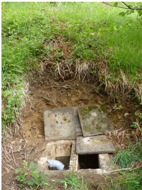
Figure 3 : A Gauche : Vue du captage protégé uniquement par quatre dalles béton et susceptible d'être contaminé par des éboulis et des eaux de ruissellement.
