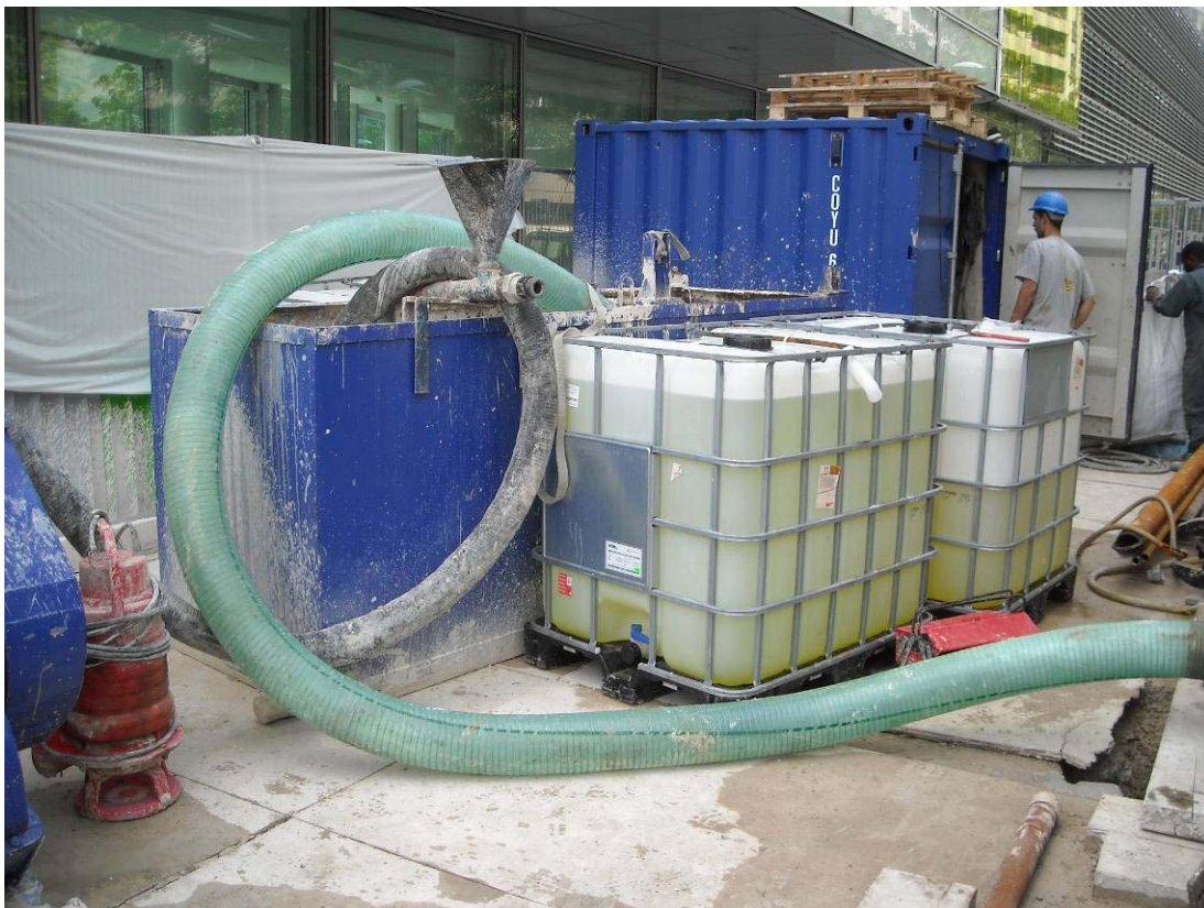
Photo 6 : Cuves d'acide chlorhydrique – forage F1
