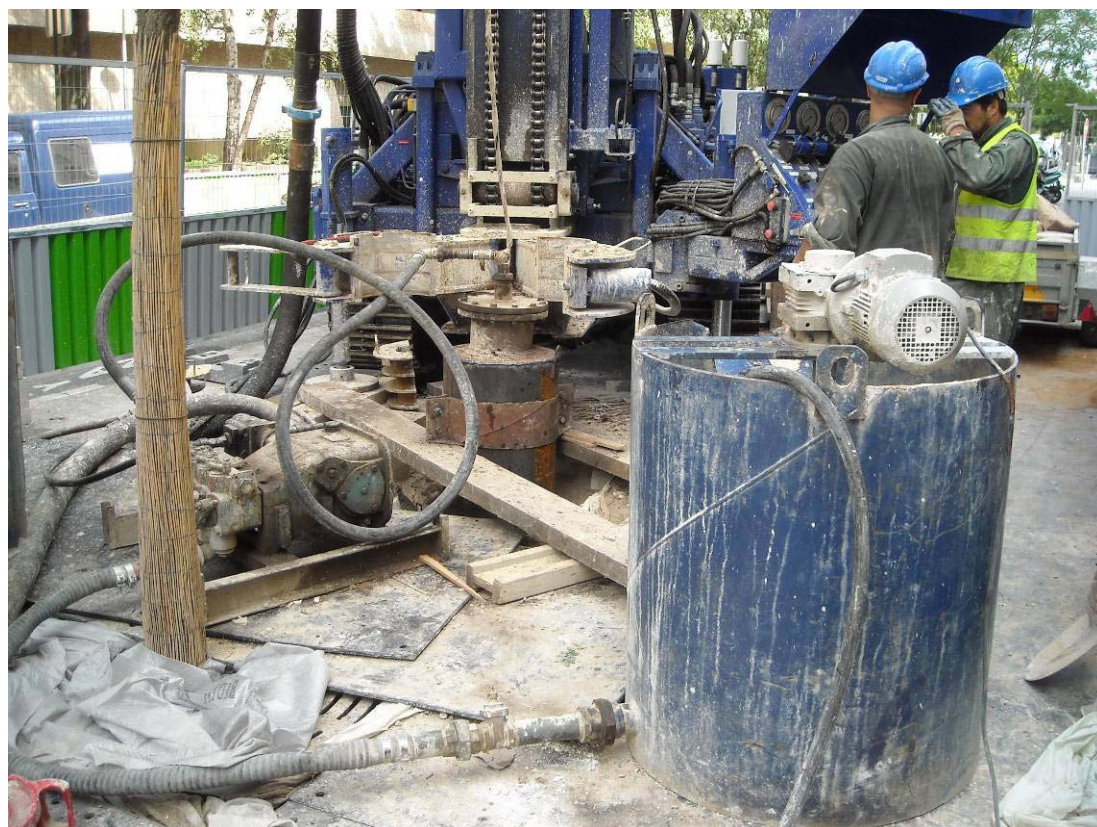
Photo 4 : Cimentation sous pression (forage F2)
