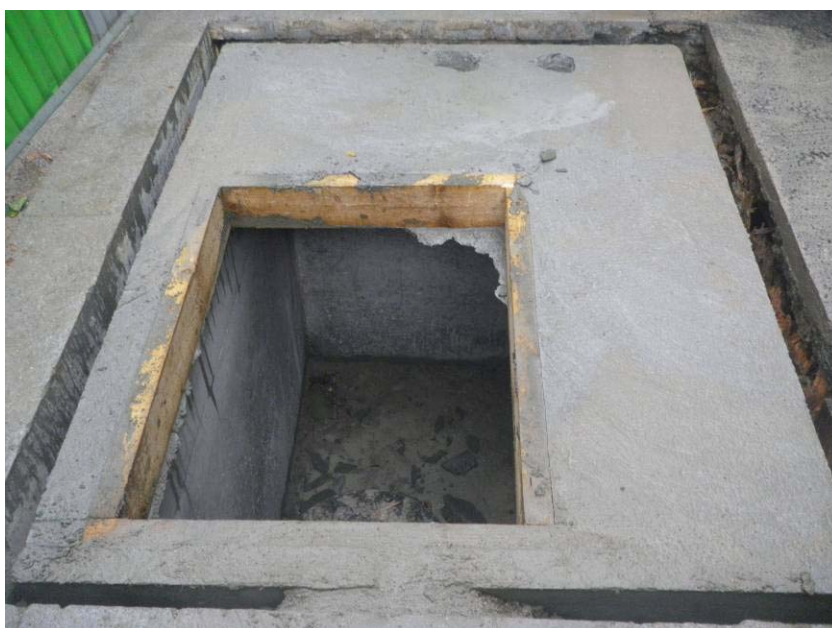
Photo 10 : Cave d'avant-puits bétonnée et dalle béton fermant la cave (destinée à accueillir une trappe à remplissage)
