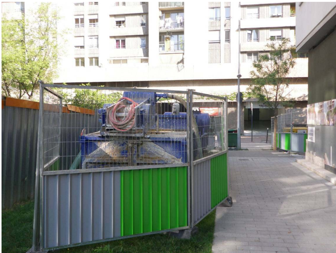
Photo 2 : Installation des bacs à boues et protections (forage F2)
