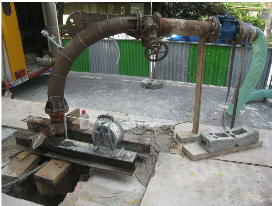
Photo 8 : Installations de pompage au forage F1
