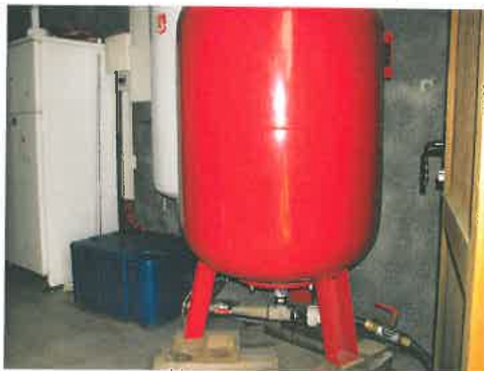
Cuve de surpression avec robinet de prélèvement
