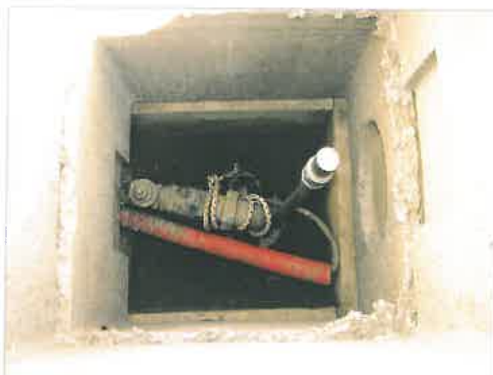
Tête du forage avec évent et orifice de mesure
