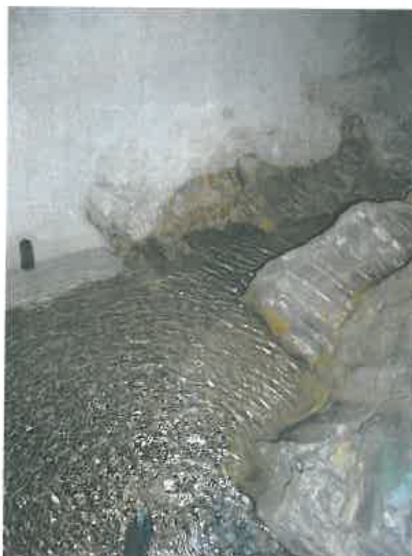
Photo 4 : Intérieur du captage : petit bassin de mise en charge avec départ canalisation crépiné en tête (en bas de la photo).
