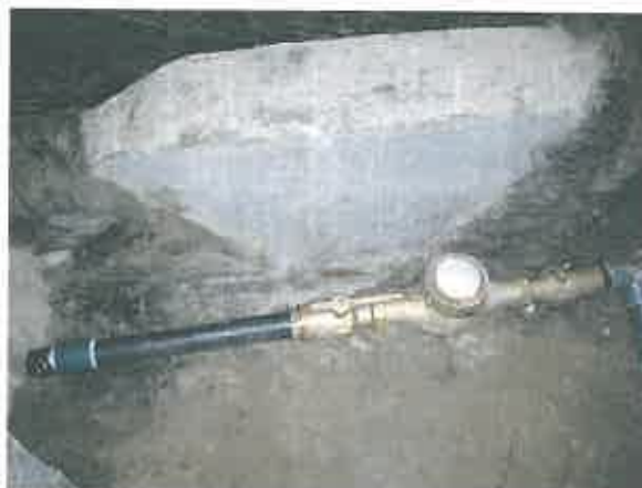
Photo 2 : Compteur de prélèvement d'eau alimentant le réservoir.
