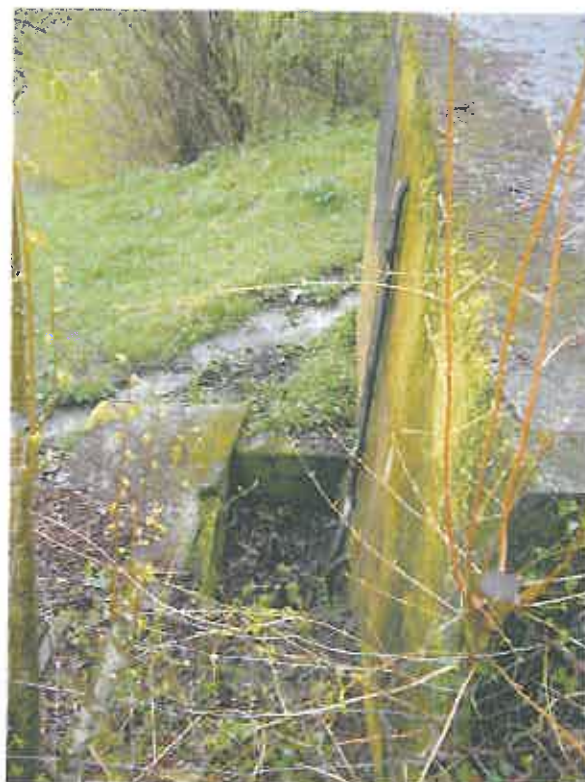
Photo 8 : Réservoir en avant du captage (autre coté de la piste). départ trop plein et conduite d'adduction, développement de mousse sur les parois
