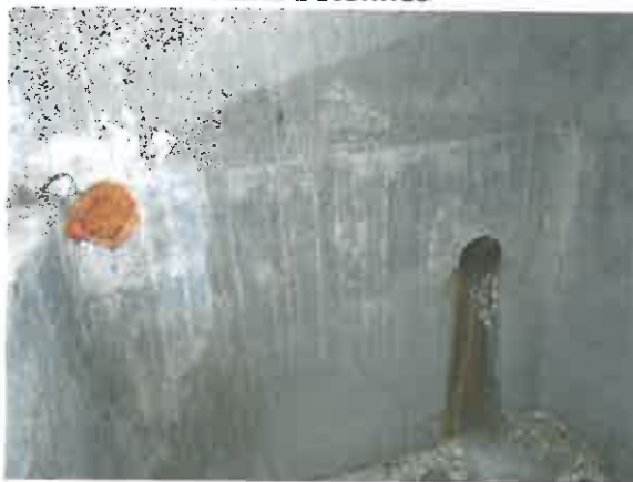
Arrivée de la source dans la chambre de reprise
