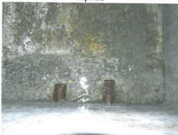
Trop-plein et distribution dans la chambre de reprise
