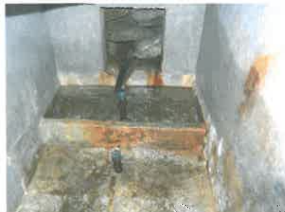
Captage des venues – chambres de décantation et de reprise
