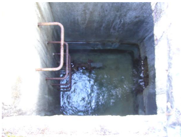
Photo 2 : Intérieur de la boîte de captage : l'eau arrive sur le coté droit ; départ de la canalisation avec crépine en tête. Le tube du trou plein crée des remous en bas à gauche
