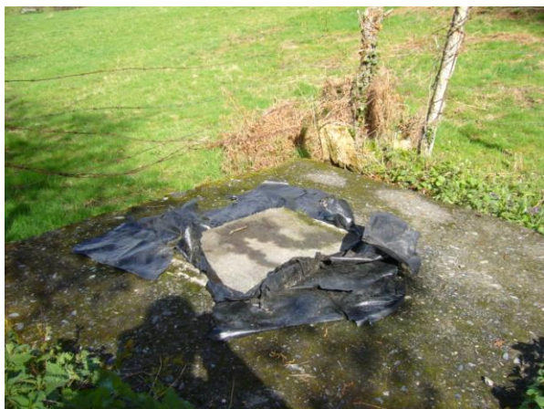
Photo 1 : Captage de la source. Dallage en béton avec ouverture protégée par un simple panneau béton sur une membrane plastique ; clôture avec piquet en bois
