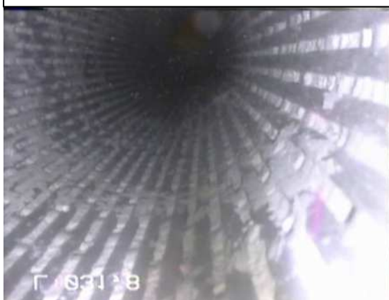
Tubage laisse apparaitre un début de dépôts fins crayeux facilement mobilisable lors du passage de la caméra.
