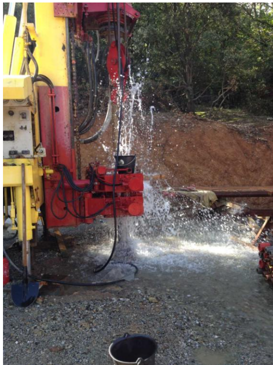
Photo 1 Nettoyage de l'ouvrage - soufflage
