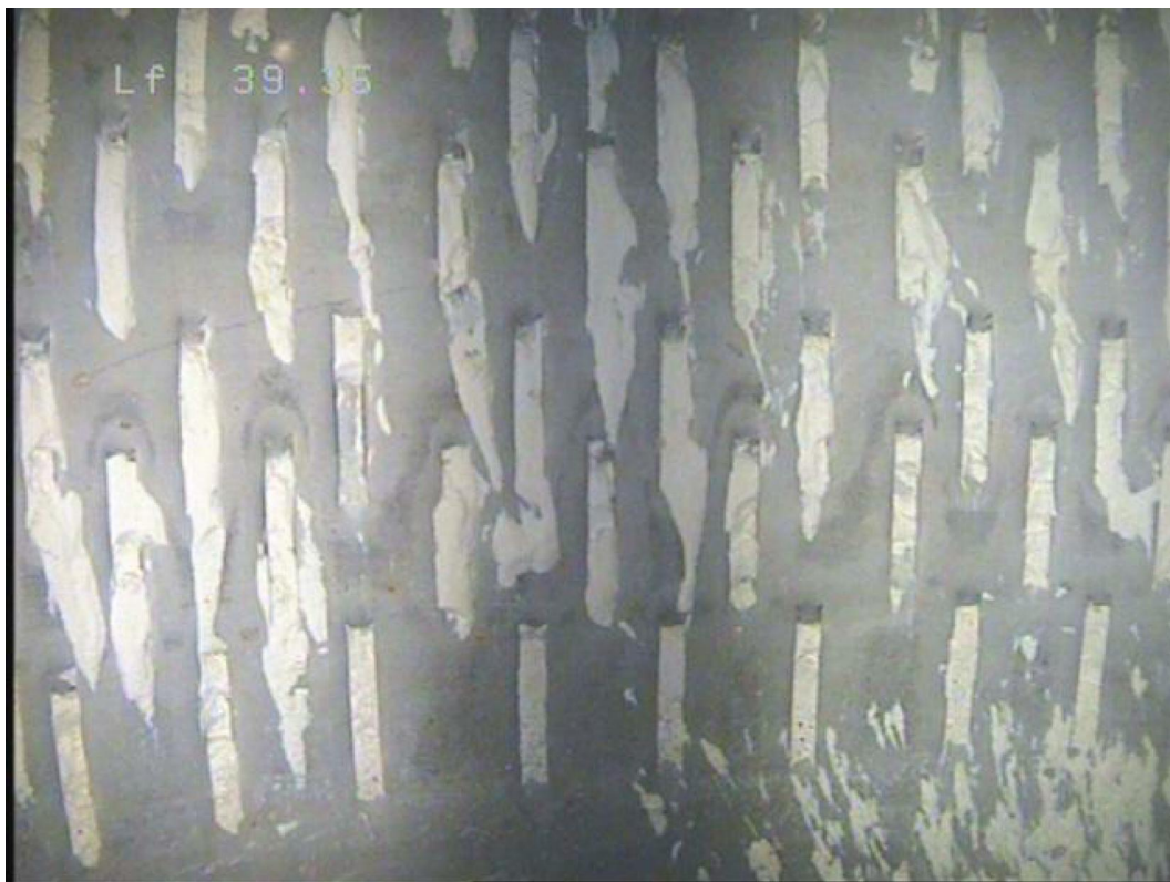
27- Tubage inox crépiné (-39.35 m) – accumulation de fines dans les fentes
