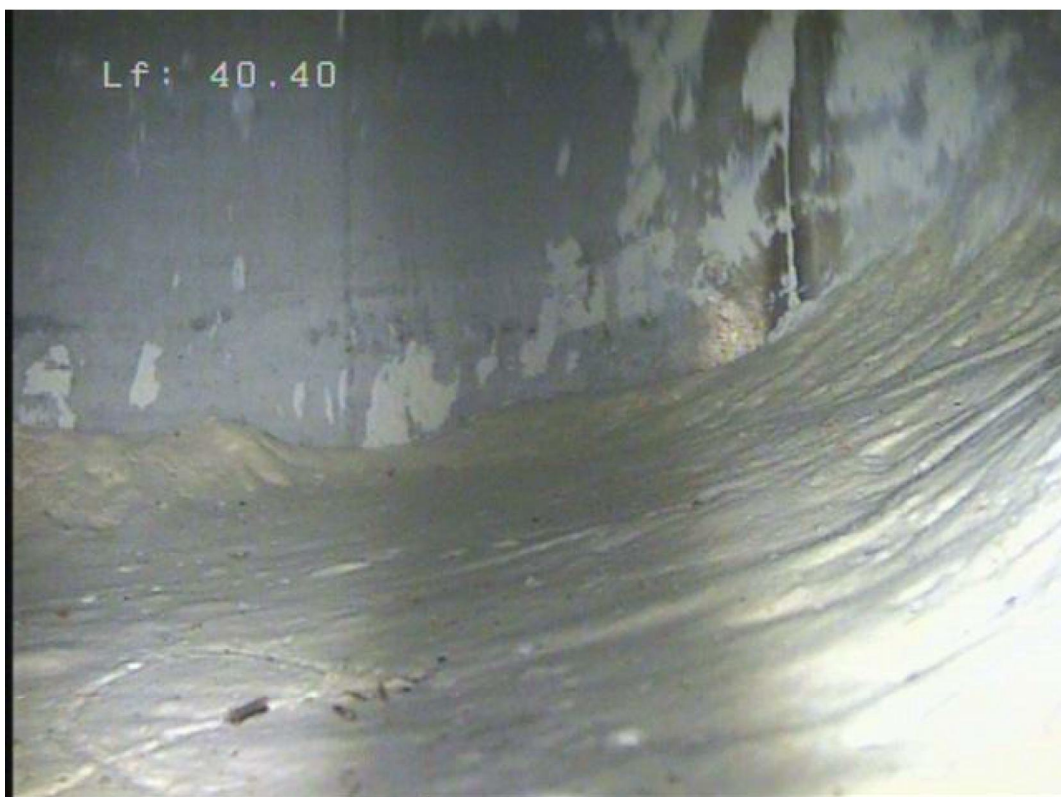
30- Fin de l'inspection télévisée – remplissage du fond par des sédiments fins et clairs
