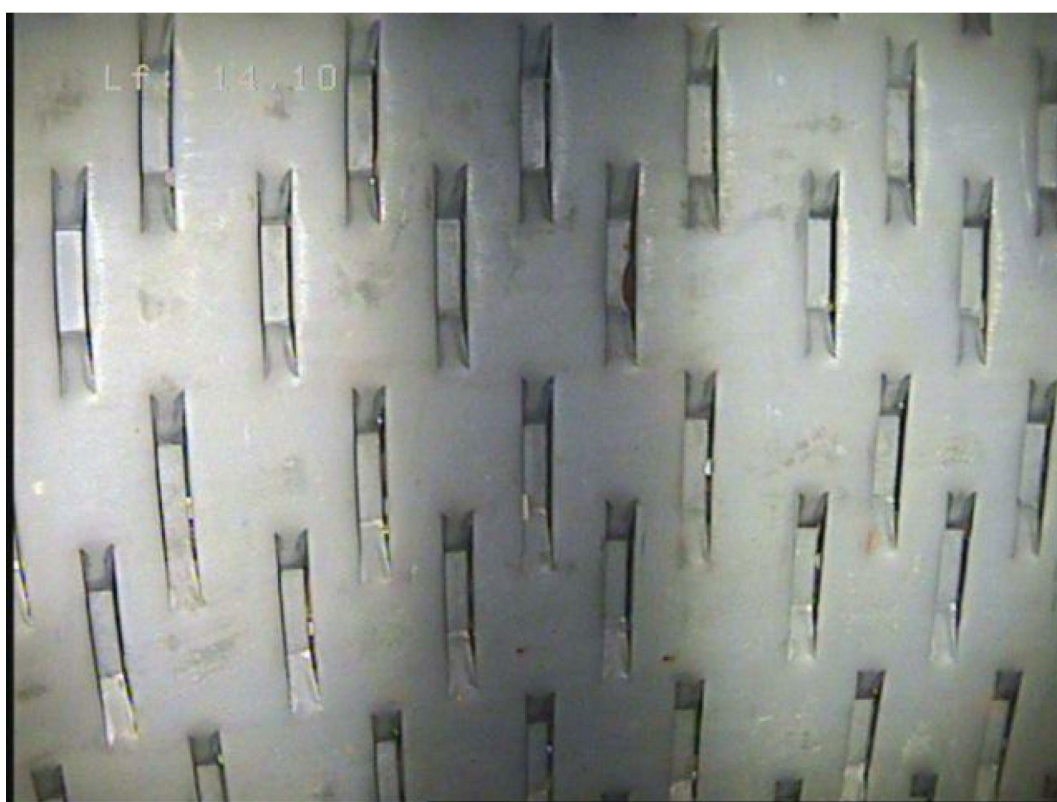
12- Tubage inox crépiné (-14.10 m) – fentes ouvertes et propres
