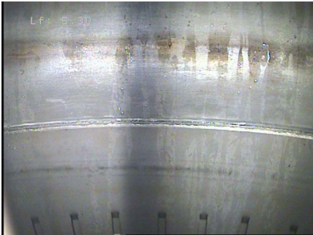
5- Tubage inox plein (-5.30 m) – raccord manchonné et tête de crépine
