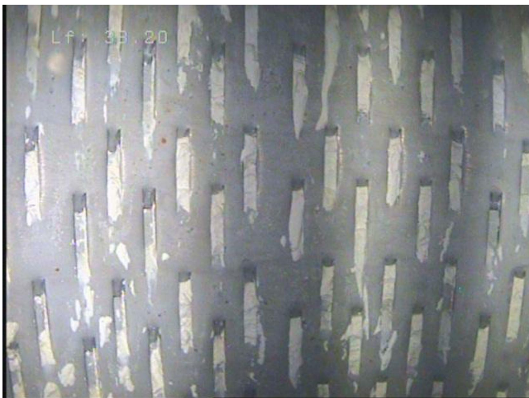
26- Tubage inox crépiné (-38.20 m) – reste de fines dans les fentes
