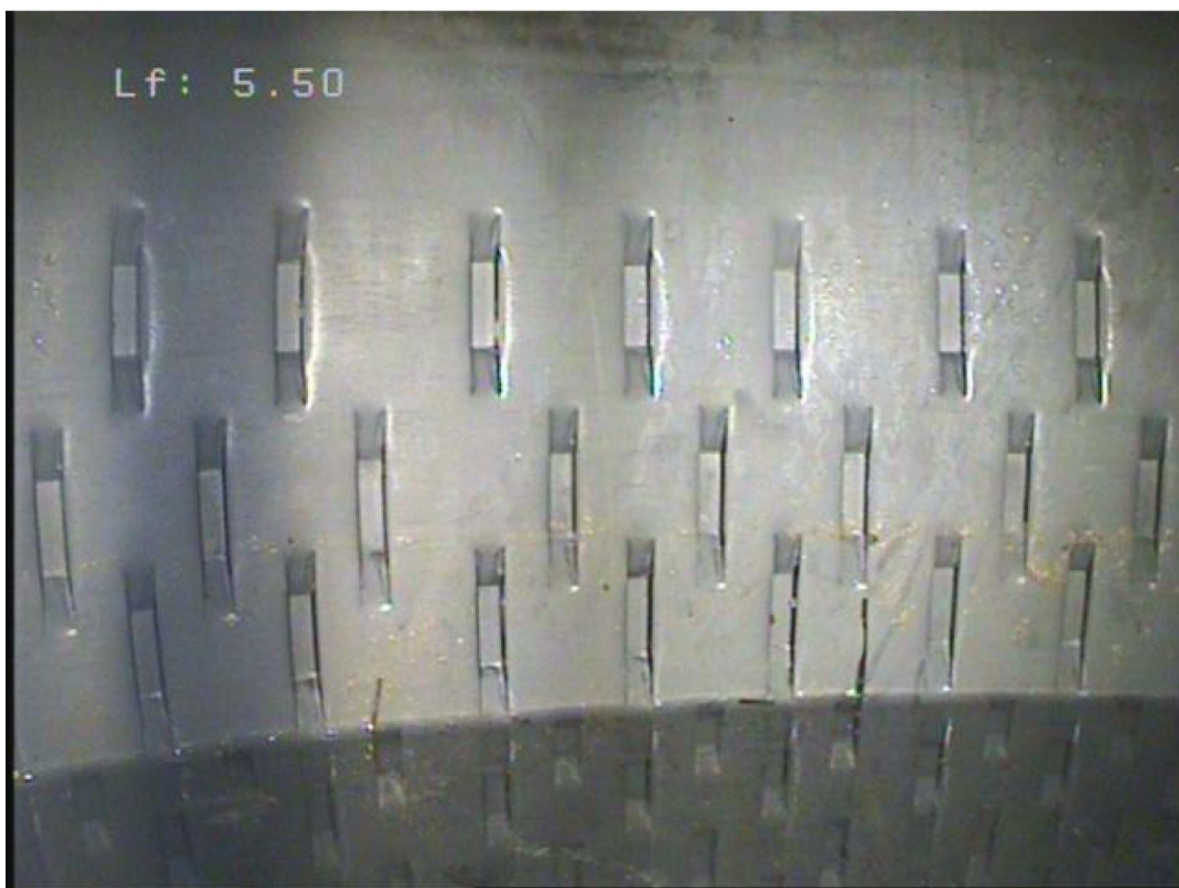
6- Tubage inox crépiné (-5.50 m) – niveau statique
