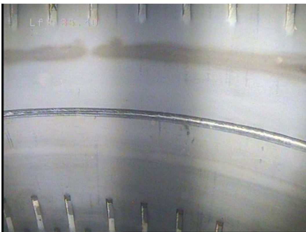
24- Tubage inox crépiné (-35.40 m) – raccord manchonné
