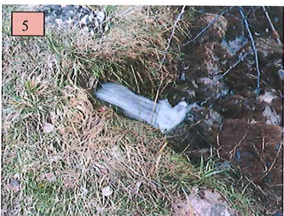
Trop plein de la station de pompage sans protection
