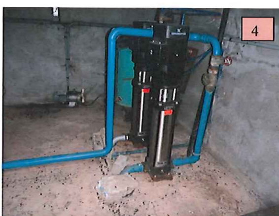
Station de pompage, pompes sur bassin crottes de rongeurs et dispositif de traitement HS
