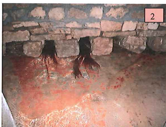
L'arrivée des dalots et les queues de renard sur le glacis cimenté
