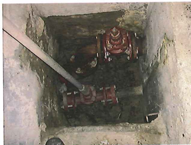
Bac de pied sec avec l'accès aux vannes
