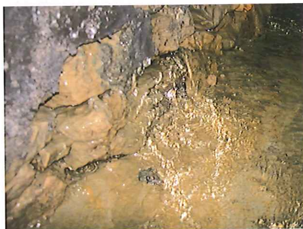
Arrivée d'eau à travers le mur bâti
