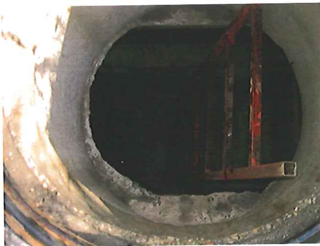
Echelle permettant d'accéder au bac de pied sec
