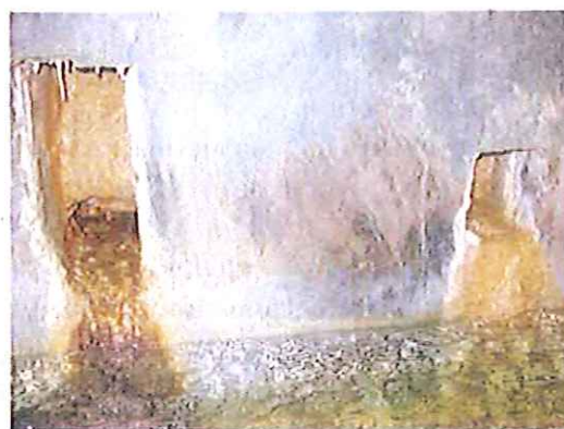
Entrées d'eau dans l'ouvrage :
