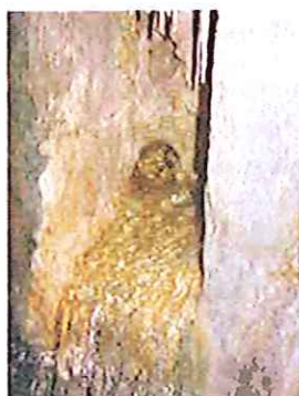
Entrées d'eau dans l'ouvrage :
