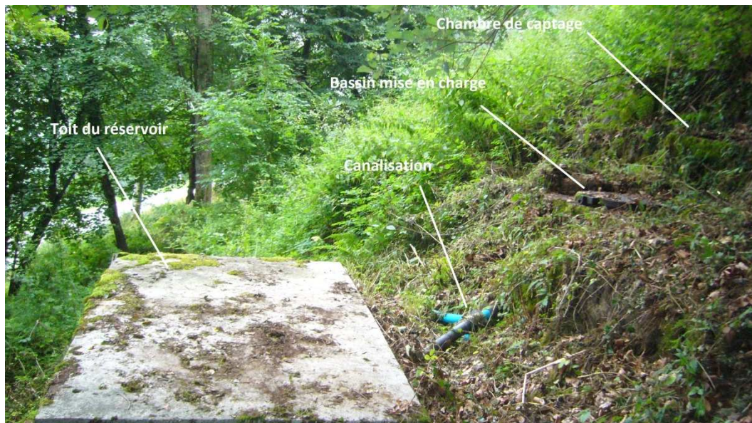
Figure 5. Photographie de l'ensemble de l'ouvrage et du bassin de Montjoye. La canalisation de transport extérieur est en surface (prise de vue réalisée le 2 août 2012)
