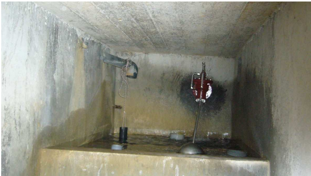
Figure 7. Vue de l'intérieur du bassin de Montjoye, en haut à gauche l'arrivée de l'eau du captage de la Source (si connectée) à droite l'arrivée du réservoir supérieur de Montjoye (prise de vue réalisée le 2 août 2012)
