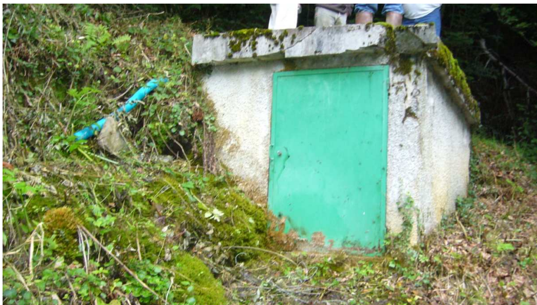
Figure 6. Vue de l'abri du bassin de Montjoye, à gauche la déconnection de la canalisation de transport, l'eau du captage ruisselle directement sur le sol (prise de vue réalisée le 2 août 2012)
