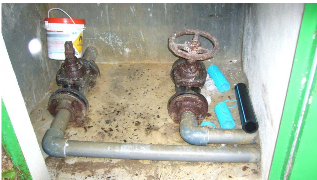
Figure 7. Vue de l'intérieur du bassin de Montjoye, en haut à gauche l'arrivée de l'eau du captage de la Source (si connectée) à droite l'arrivée du réservoir supérieur de Montjoye (prise de vue réalisée le 2 août 2012)
