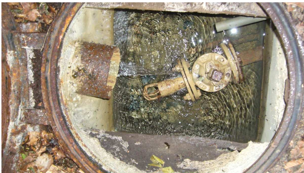
Figure 4. Photographie de l'ouvrage de mise en charge en aval du captage. Arrivée de l'eau à gauche, départ à droite avec vanne et trop plein PVC (prise de vue réalisée le 2 août 2012)
