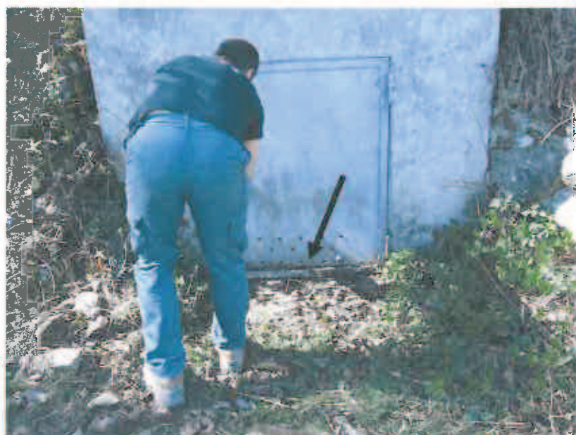
Porte du captage à restaurer et assainissement pluvial autour du captage à réaliser
