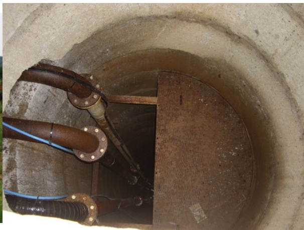
Intérieur du puits avec tubes d'exhaure traversant la paroi sous le niveau du sol
