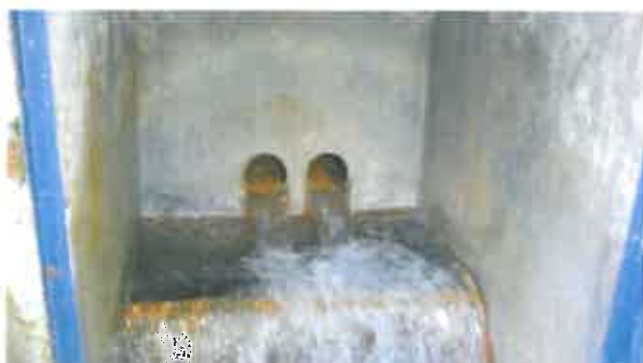
Photo 11 : Intérieur de l'ouvrage de distribution dans lequel arrivent 2 canalisations en PVC avec bassin de décantation et bassin d'alimentation
