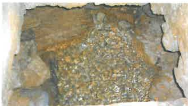
Photo 10 : Intérieur de l'ouvrage de captage d'où partent deux tuyaux en PVC de 150 mm ; eau claire, jamais turbide
