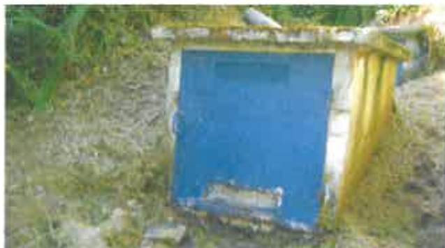
Photo 9 : Ouvrage de distribution au 1 er plan et le captage au 2 ème plan en petite maçonnerie, portes métalliques
