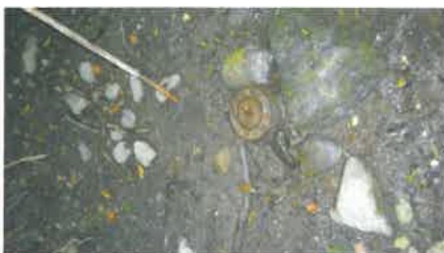
Photo 3 : Bouche à clé pour disconnexion du réseau d'alimentation en amont du réservoir de St-Germés
