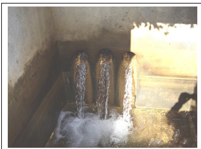
Trois buses d'arrivée dans le bassin de captage
