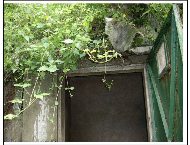
Toit en partie détérioré et prêt à chuter
