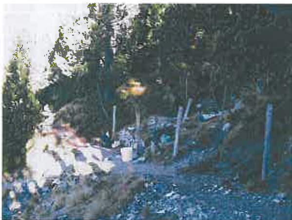
Photo 3 : Vue générale du captage. La source est au-dessus du GR10. Piquets en bois du périmètre de protection immédiat mais sans clôture.
