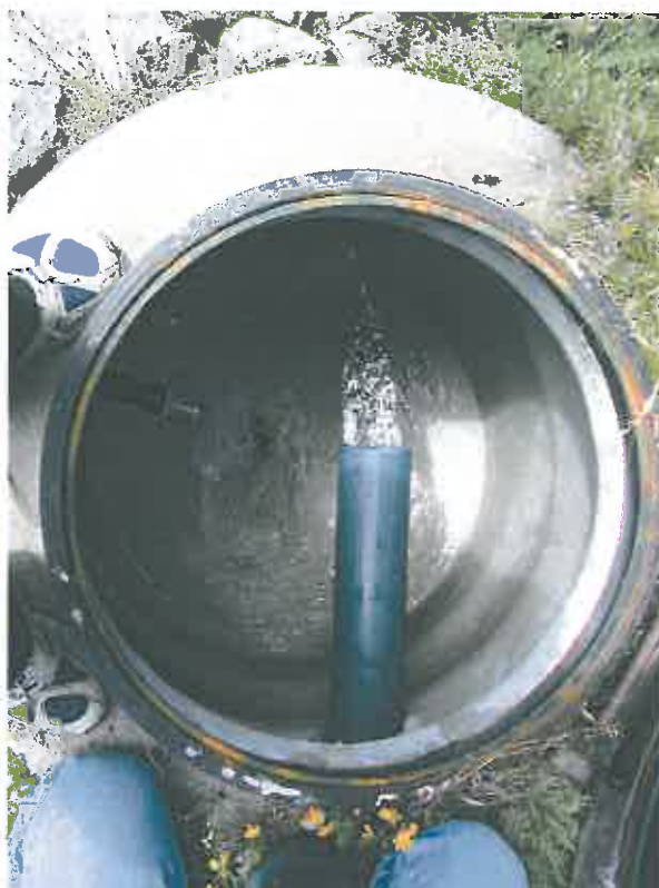
Photo 2 : l'eau arrive par tube PVC Ø 100 mm avant de repartir vers le réservoir par une conduite Ø 50 mm munie d'une crépine.
