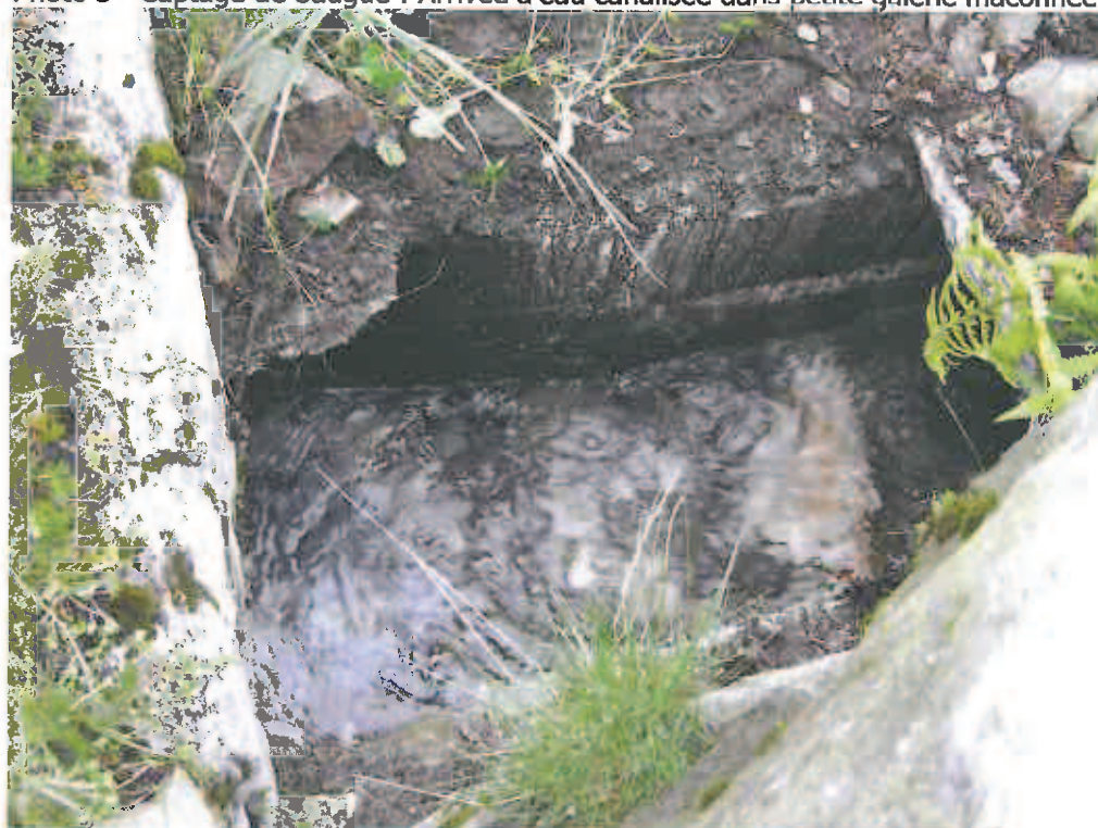
Photo 3 - Captage de Saugué : Arrivée d'eau canalisée dans petite galerie maçonnée
