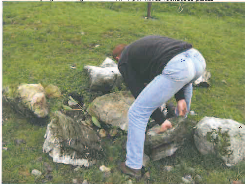
Photo 2 - Captage de Saugué – Fermeture par dalles rocheuses plates
