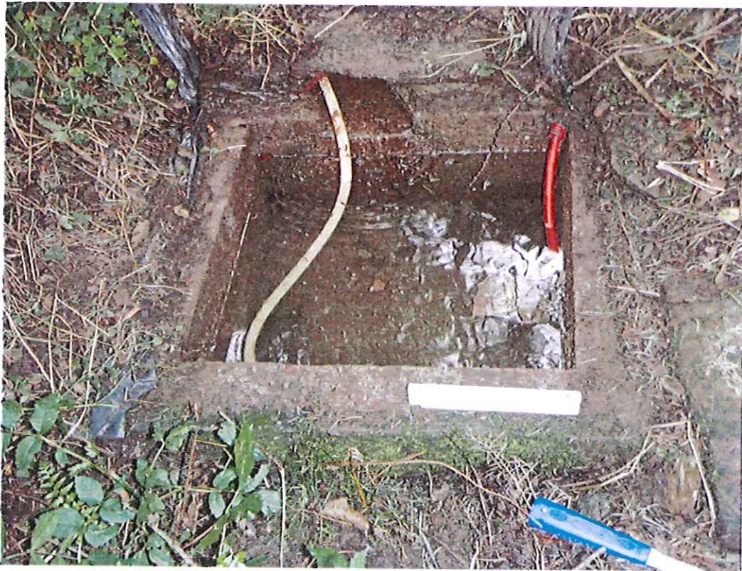
Figure n° 6 : vue de l'intérieur du regard du captage de la source « Font Mal ». (Cliché : Jean-Louis LENOBLE, 31/08/16).
