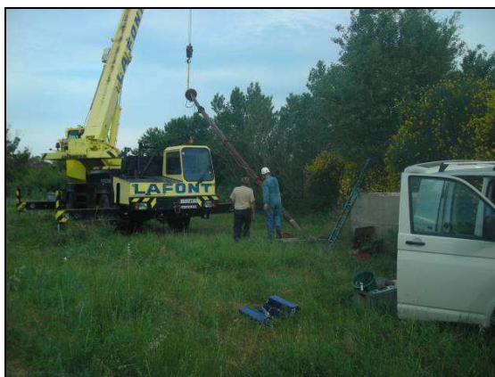
Figure 7 : Dépose de la colonne et de la pompe sur le sol
