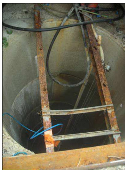
Figure 36 : Buses béton en tête de l'ancien forage
