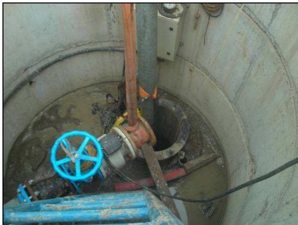
Figure 49 : Colonne d'exhaure 150 mm acier galvanisé
