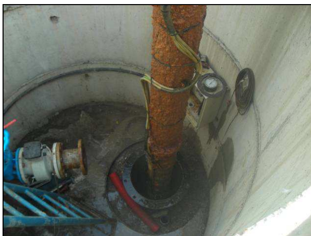
Figure 21 : Colonne d'exhaure et pompe d'exploitation
