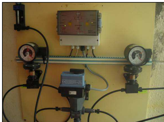
Figure 18 : Affichage du débitmètre et tableau électrique
