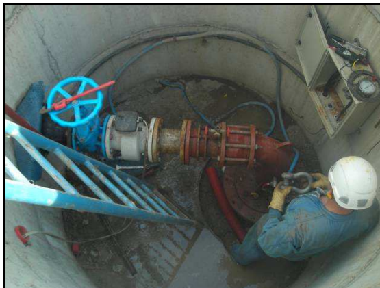
Figure 5 : Déconnexion hydraulique de la colonne
