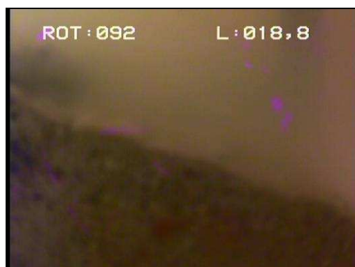
Figure 31 : Fond de l'ouvrage après air-lift
