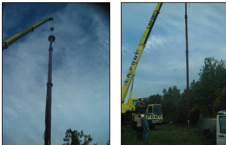
Figure 6 : Levage de la colonne à l'aide d'une grue
