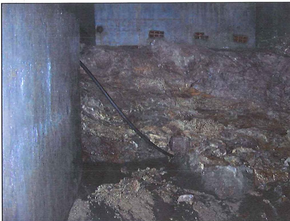
A noter à la partie supérieure, 3 briques creuses, un orifice circulaire, et en partie latérale un départ de galerie interrompu après quelques décimètres et duquel sort un tuyau type "Plymouth", sec lors de notre visite.
