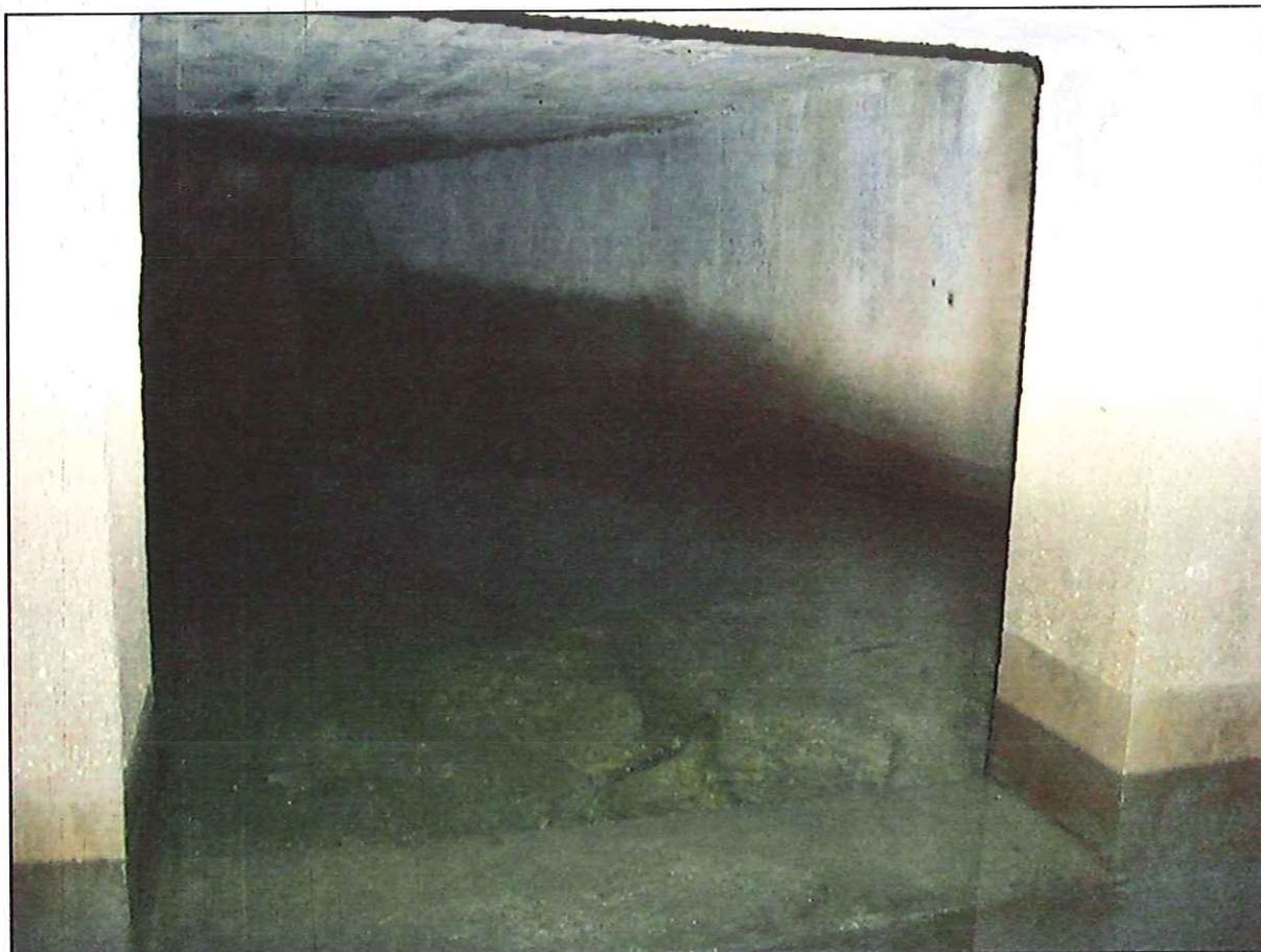
Latéralement une ouverture de 0,85 m x 0,60 m débouche sur une galerie profonde de 5 m au fond rocheux, parois latérales bétonnées. Le(s) griffon(s) n'est (ne sont) pas visible(s) ; aucune information fournie.
