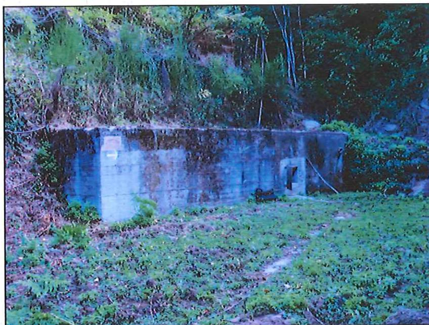
Il se présente par un bâti ancien, en béton, long de 8 m, adossé au relief et comportant une petite ouverture de 0,35 m x 0,40 m, munie d'une porte métallique cadénassée, non étanche. Cette ouverture débouche sur une petite salle de 1 m de côté limitée latéralement par des galets ronds roulés et au fond de laquelle le rocher fissuré laisse s'écouler un débit de 410 l/h le 21 septembre 2012 (mesure dans le regard enterré à 10 m du captage). Il s'agit de la
