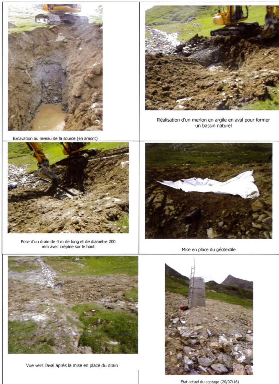
Figure 7 : photographies des travaux de captage - source ETEN
