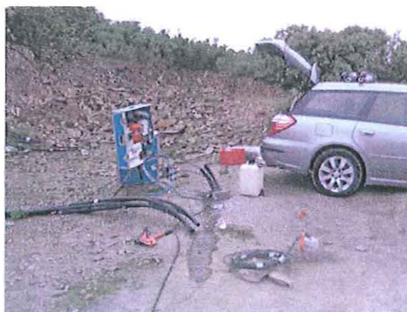
Figure 5. Préparation de la sonde géothermique verticale et du Mini-module de chauffage.
