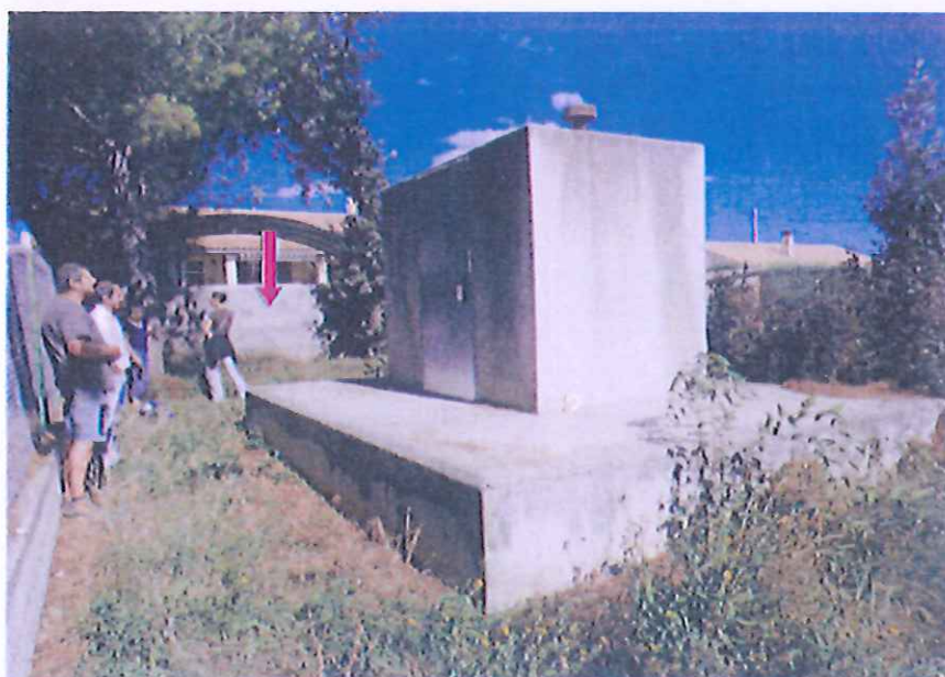
Le local forage sur la dalle en béton. Au fond, la flèche indique le mur mitoyen à rehausser d'un grillage de 0,60 m de haut.
