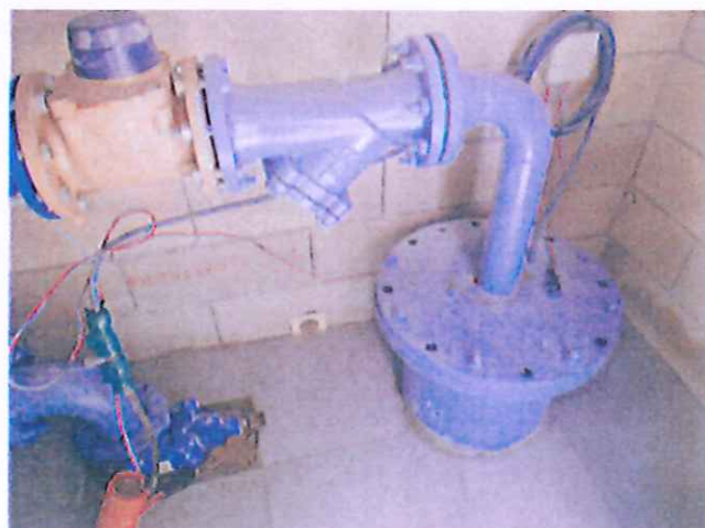
La tête de forage et le compteur à l'intérieur du local carrelé.
