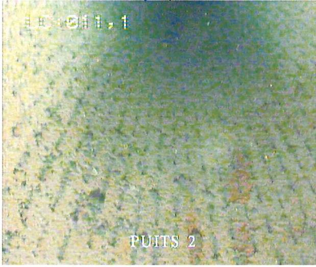
16,4m : La paroi du tubage est recouverte de gros dépôts bruns. Les ouvertures sont colmatées à 100% par ces dépôts bruns.
